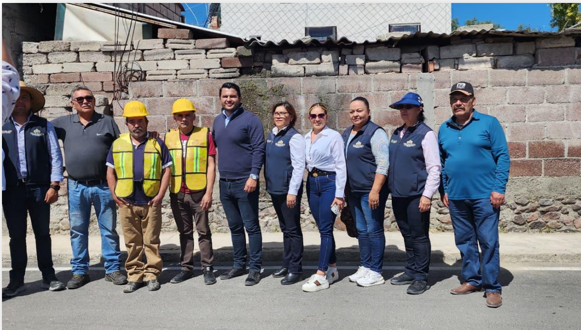
Registro Fotográfico tomado con dispositivo móvil durante la entrega de obra de Pavimentación Asfáltica en Cabecera Municipal. "27/07/2026".
