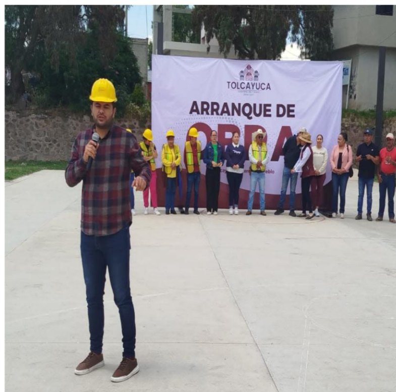
Fotografía propia tomada con dispositivo móvil durante el arranque de obra de la rehabilitación de la cancha de fútbol en la comunidad de Vicente Guerrero (06/09/2025).
