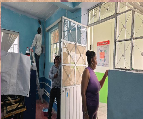
Se gestiona el apoyo con el personal para pintar el salón de la escuela Vasco de Quiroga en Santiago.
