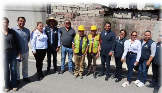
Pavimentación asfáltica de la calle Pino Suárez de la Colonia Satélite de la Cabecera Municipal con un total de 2,127.66 metros cuadrados. 27 de octubre 2025
